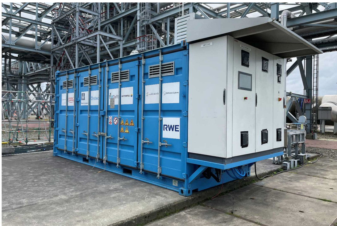
Figuur 1.1 Battolyser op industriële schaal bij RWE Magnum energiecentrale (Foto: (RWE, 2023))
