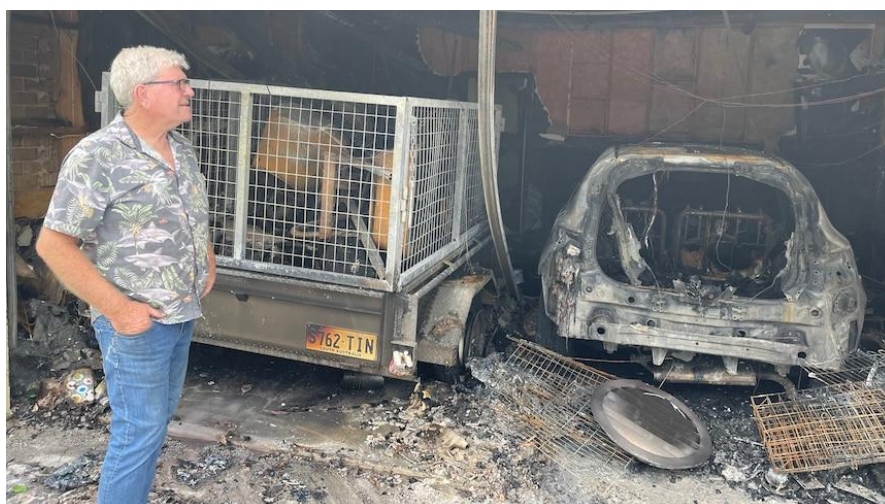
Schade na het incident met de thuisbatterij
