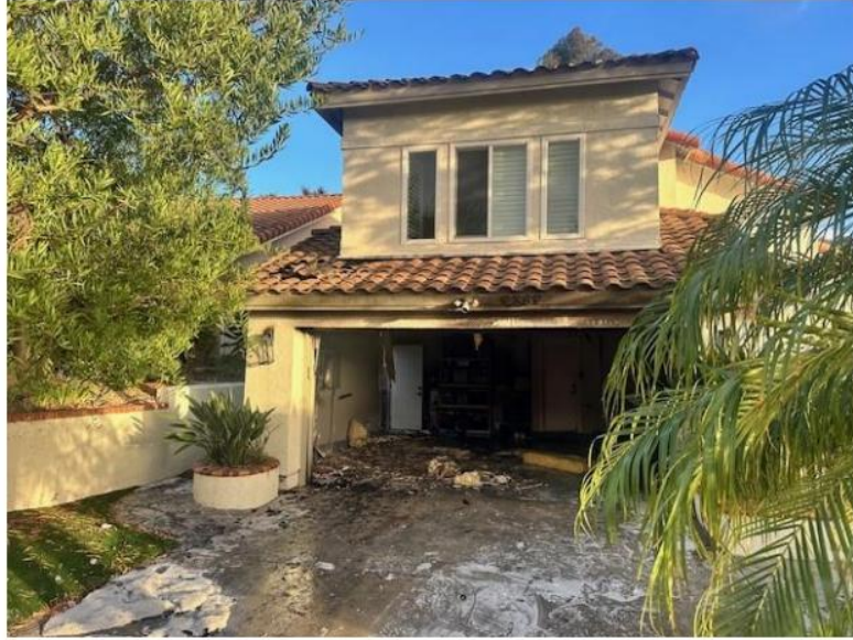
Locatie waar het incident heeft plaatsgevonden en de schade
