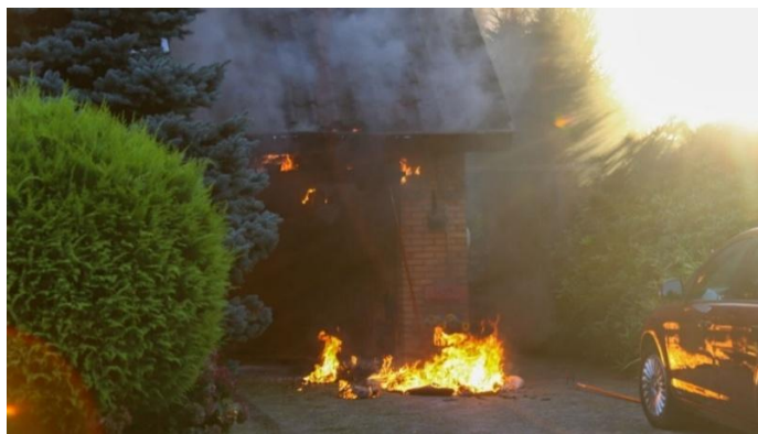
Situatie bij aankomst van de brandweer (Brandweer Twente, 2023)
