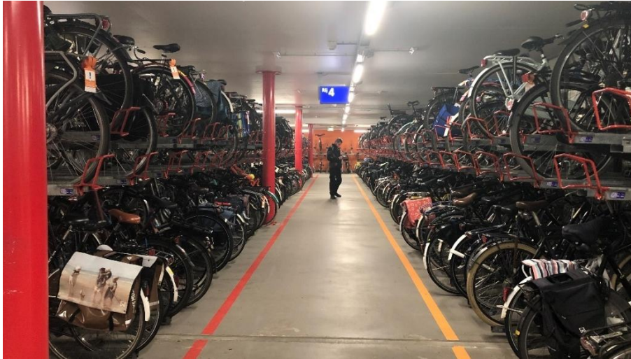
Figuur 2.8 Inpandige fietsenstalling op station Apeldoorn
