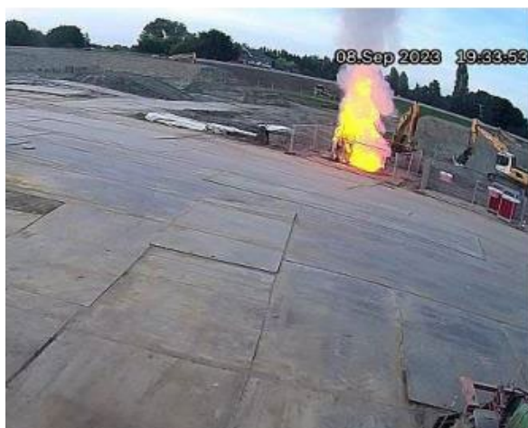
Figuur 8.3 Het aggregaat staat volledig in brand (VRU, 2023).
