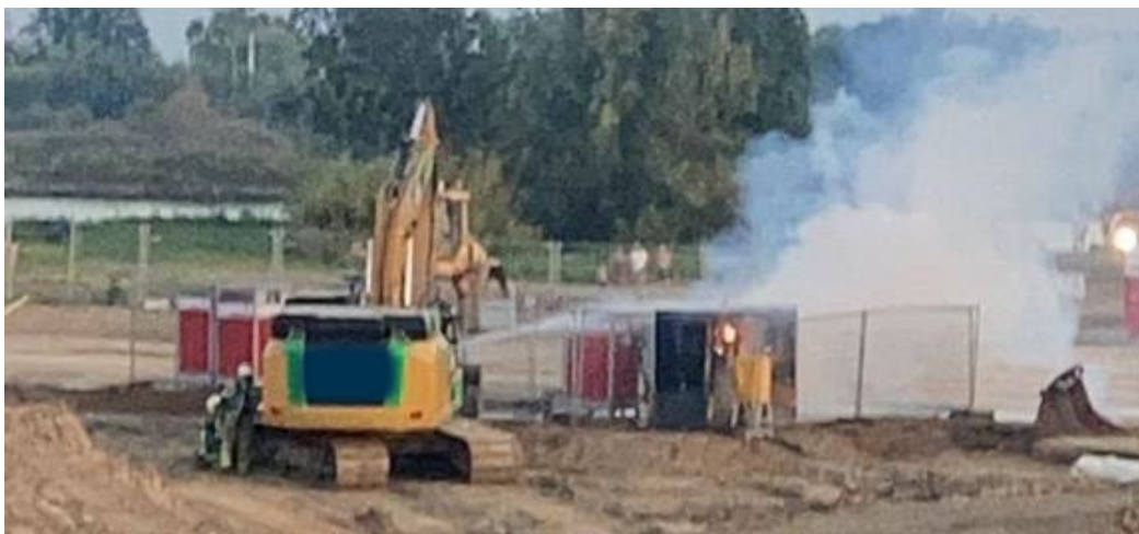
Figuur 8.5 Brandweerlieden koelen de waterstofcilinders (VRU, 2023).
