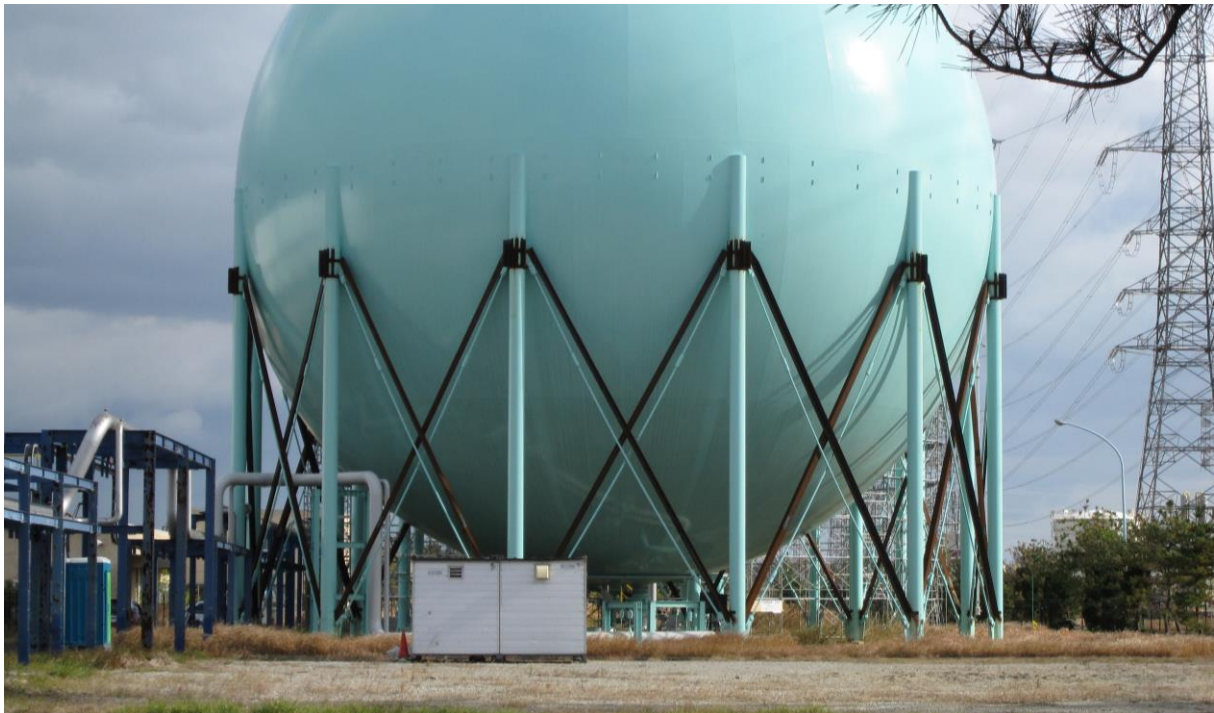
Figuur 13. Additionele riemen om de steunpilaren van een bolvormige opslagtank te versterken tegen aardbevingen (Foto: E. Krausmann)
