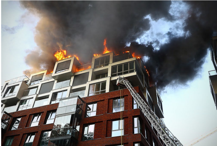
Figuur 3.2 Casus 'opgetopt woongebouw', met in lichtgrijs het opgetopte deel (bron: Jeffrey Koper Brandweer Amsterdam-Amstelland)
