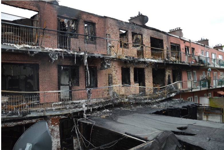
Figuur B2.4 Achterzijde woongebouw. Bron: TBO Haaglanden
