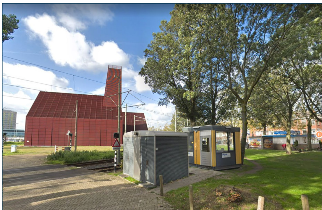
Figuur 1.2 Boven: Aardwarmte-installaties bij tuinderij in Honselersdijk. Onder: de aardwarmte-installatie van de Haagse Aardwarmte Leyweg (HAL) is visueel weggewerkt door een verhullende facing
