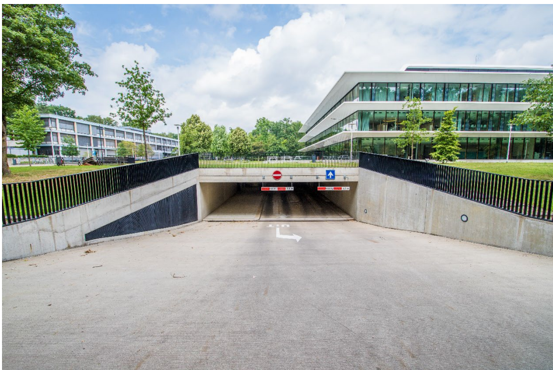
Afbeelding 5.4 Ondergrondse parkeergarage (bron: Tom Hessels, IFV)
