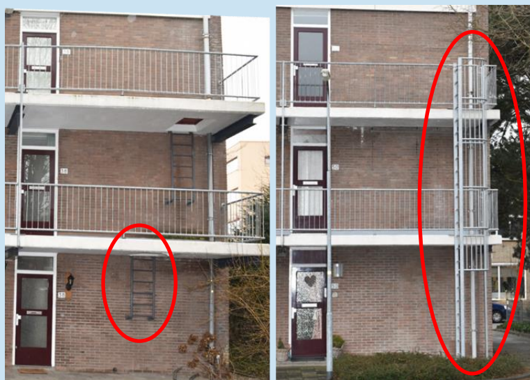
Figuur 2.2 Links een voorbeeld van een vluchtluik, rechts een vluchtladder (Bron: Brandweer Gelderland-Midden)
