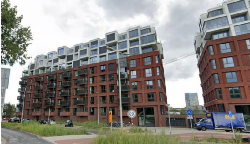
Figuur 1.2 Het woongebouw
