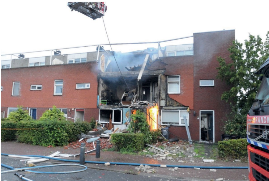
Figuur 2.2 Schade aan de voorkant van de woningen
