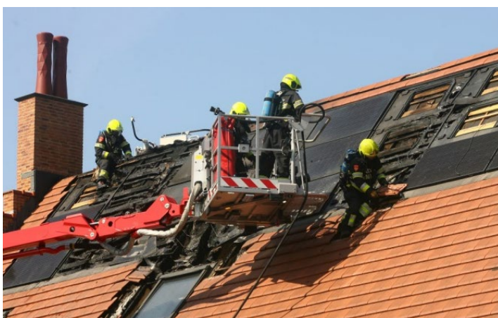
Figuur 1.6 Het demonteren van PV-panelen door eenheden van de hoogwerker
