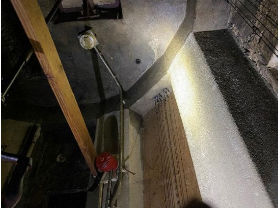
Figuur 1.1 De rookmelder en slow whoop in de ruimte van het klavier
