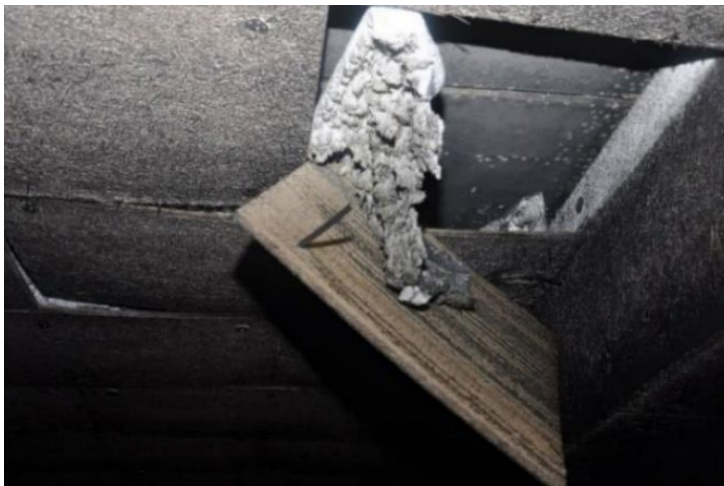
Figuur 4.1 Houtwolcementplaat met gesmolten EPS
