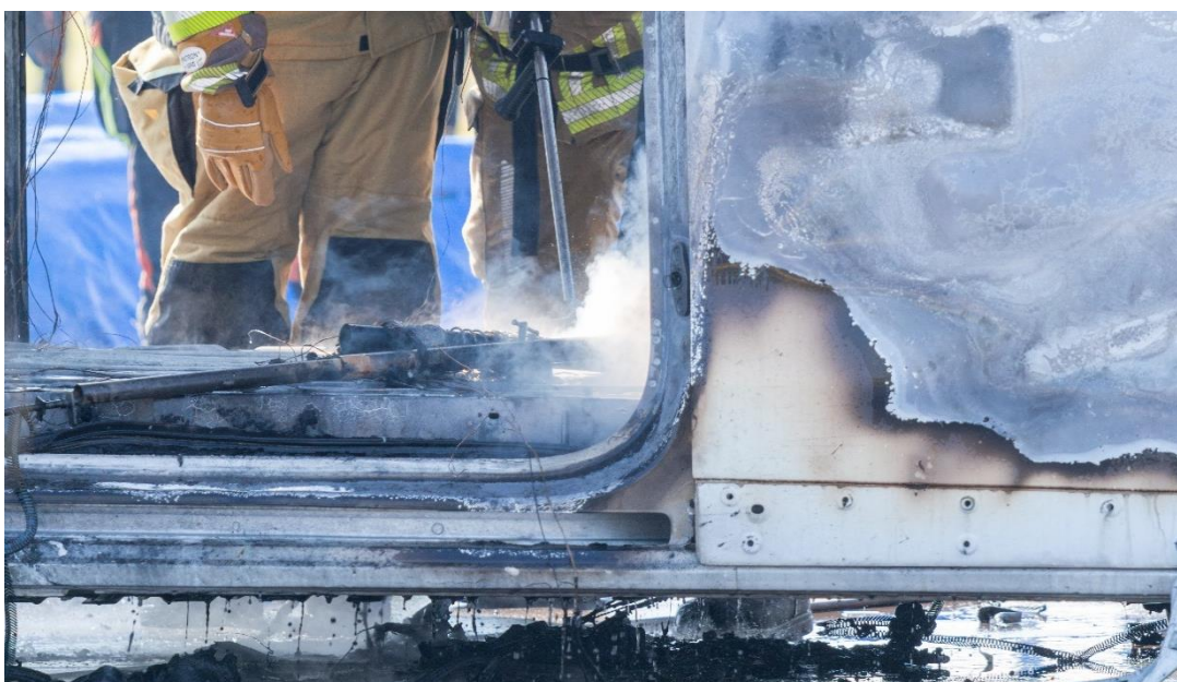
Figuur 5.2 Stoomvorming tijdens inzet uhd-blussysteem
