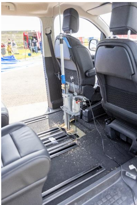
Figuur 4.1 Opstelling boormachine
