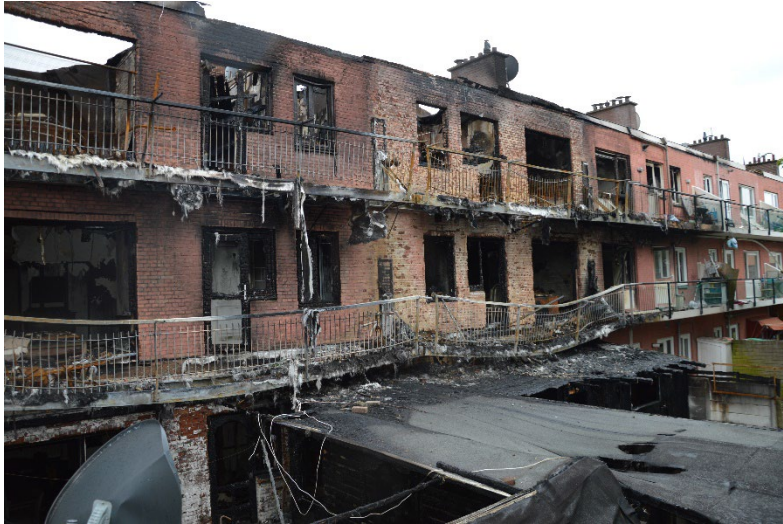
Figuur B2.4 Achterzijde woongebouw. Bron: TBO Haaglanden
