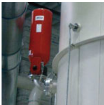
Voorbeelden explosieonderdrukkingssystemen (Bron ATEX-international)
