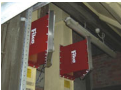
Vlamdoovers op een bucket elevator
