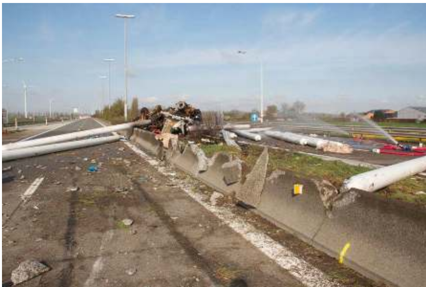
Afbeelding 7.2 De ravage op de snelweg (foto: Hulpverleningszone Waasland)
