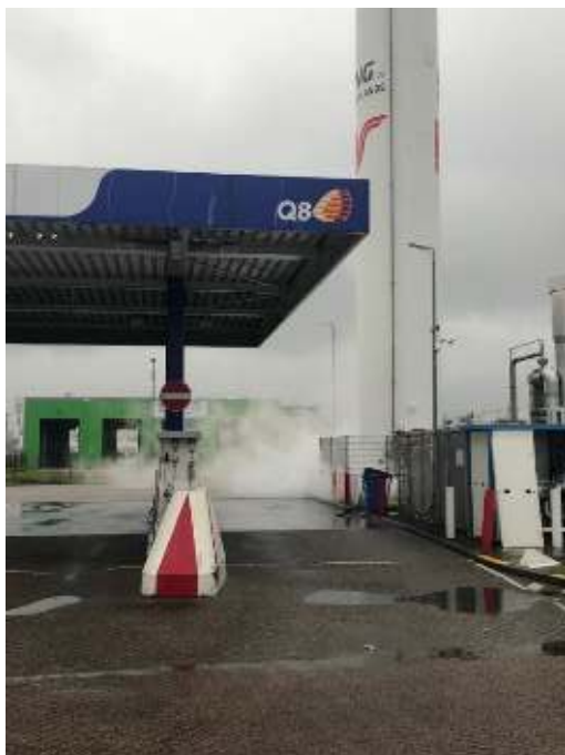
Afbeelding 8.1 Lekkage van de LNG-tank (foto: Veiligheidsregio Rotterdam-Rijnmond)
