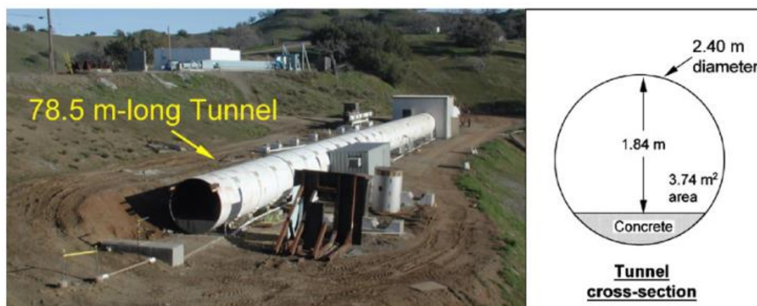
Figuur 7.1 De tunnel die gebruikt is in de experimenten van Groethe (bron: (Groethe et al, 2007))
