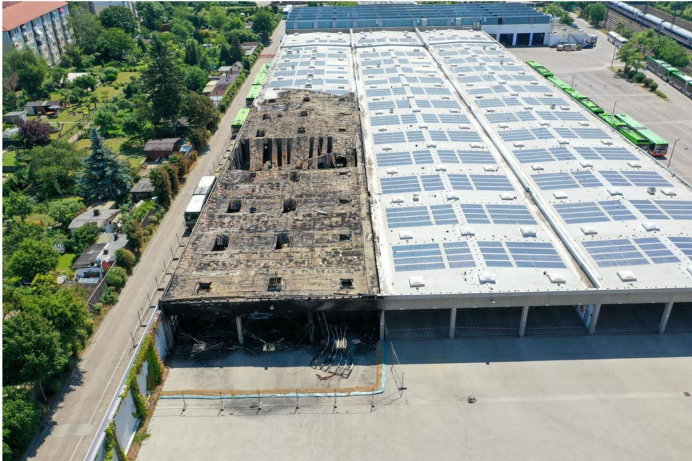
Figuur 3.2 Uitgebrand compartiment busstalling in Hannover (bron: Üstra, verkregen via GVB Amsterdam)
