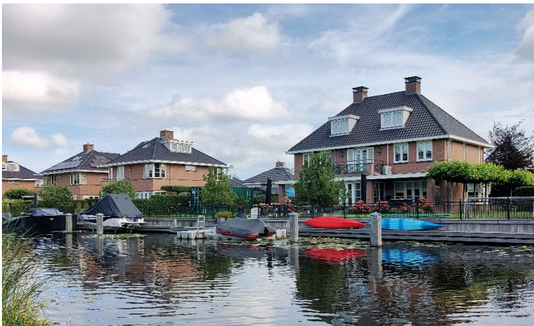
Figuur 4.4 Foto van enkele aanlegplaatsen op een smal gedeelte ongeveer halverwege de Greveling, genomen vanaf punt B in Figuur 4.2. Merk op dat aan de noordzijde vier dukdalven zijn geplaatst. 7
