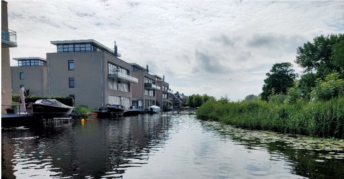
Figuur 4.3 Foto van het meest westelijk gelegen meetpunt uit Figuur 4.2, genomen vanaf punt A in Figuur 4.2. Hier is momenteel de vaarwegbreedte van de Greveling op zijn smalst. Merk op dat aan de noordzijde (links op foto) gele boeien zijn geplaatst. 7
