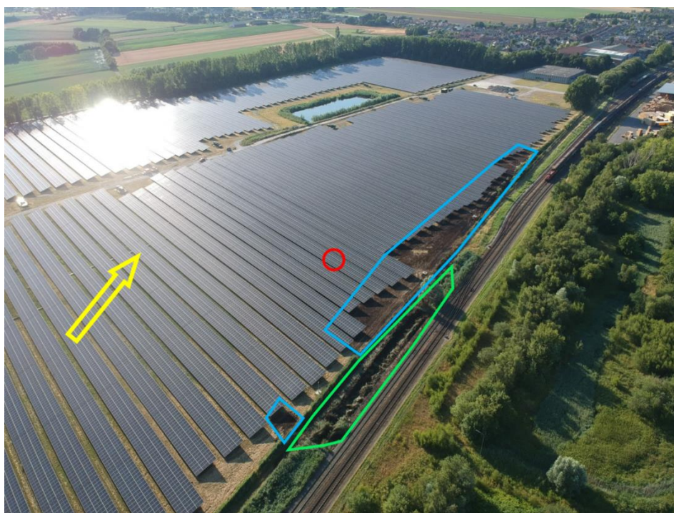
Figuur 3.2 Luchtfoto van het zonnepark, met in rood het zonnepaneel in rij 37 dat de brand heeft veroorzaakt, in blauw het deel van het terrein dat gebrand heeft en in groen het deel van de sloot dat gebrand heeft. De gele pijl geeft de windrichting aan (TBO Zeeland, 2022).
