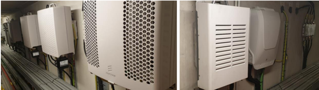
Figuur B4.2 Voorbeeld van kunststof kasten / afdekplaten ten behoeve van de tunnelinstallaties
