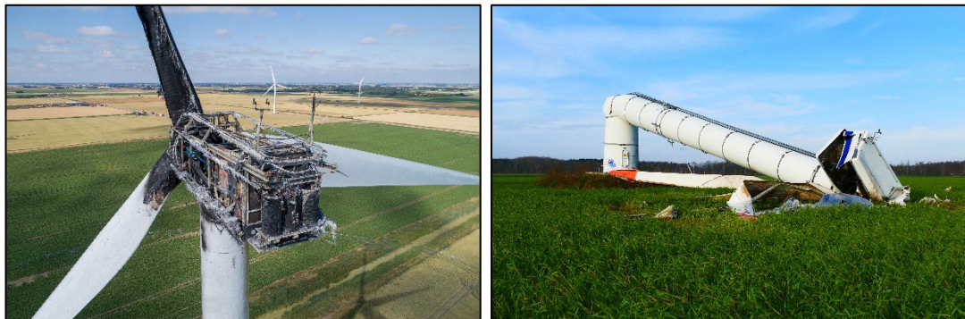
Figuur 5.1 Links: gondel die door blikseminslag in brand is geraakt. Rechts: mast die door een storm geknakt is (Foto's: Shutterstock)
