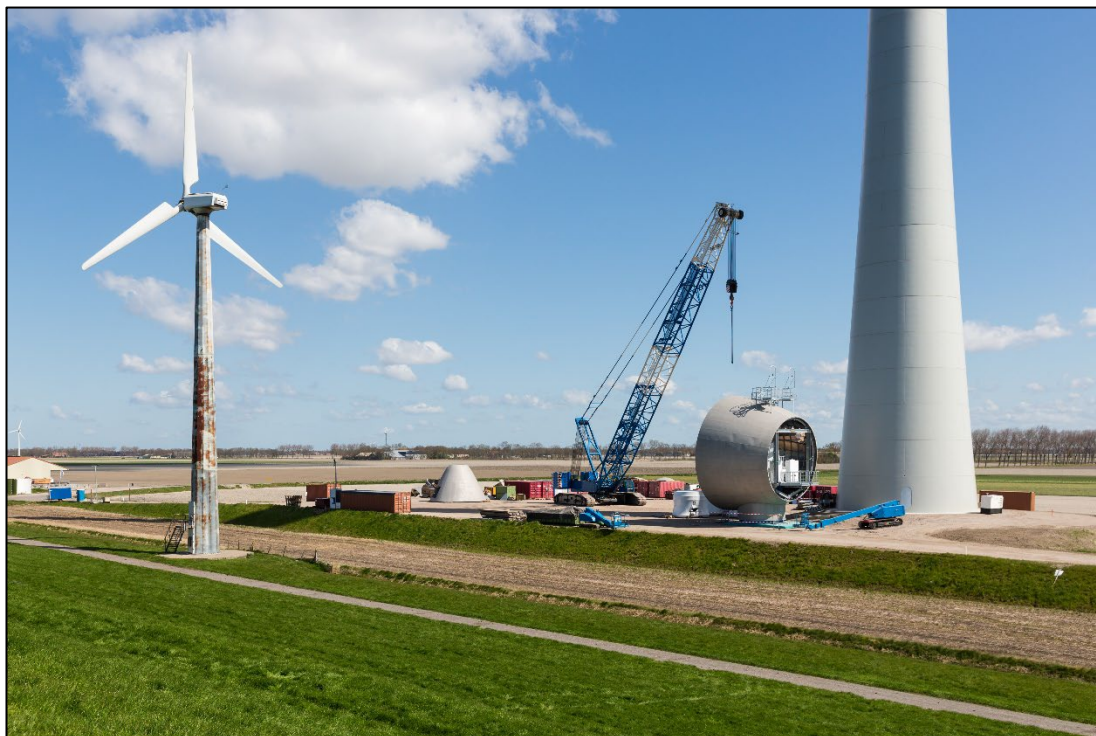
Figuur 3.1 Windturbine in aanbouw (Foto: Shutterstock)
