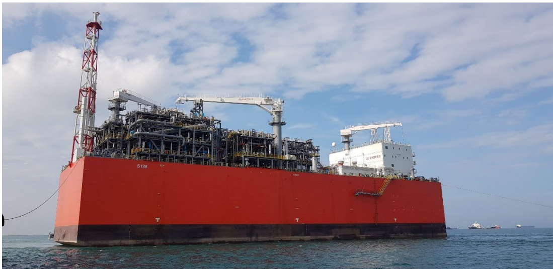
Figuur 1.1 LNG-terminal in Eemshaven. (Foto: Beeldbank EemsEnergyTerminal)
