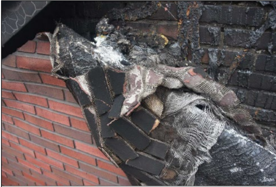
Figuur 4.1 Door brand uitgezakte isolatie met steenstrips met eronder de originele buitengevel (foto: Goos Janssen)
