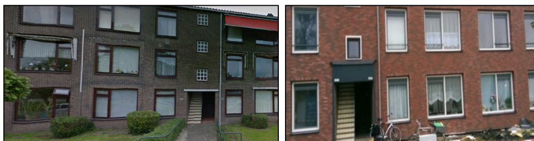
Figuur 3.1 Woningcomplex voor (links) en na (rechts) verduurzaming. De woningen zijn voorzien van gevelisolatie, dakisolatie, zonnepanelen en nieuw glas. Het enige wat herkenbaar is, is de trap die toegang geeft tot de boven gelegen woningen (foto: Goos Janssen)
