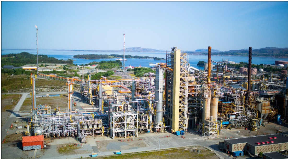
Figuur 1.2 Plant in Mongstad (Noorwegen) voor het uitvoeren van testen met betrekking tot het afvangen van CO 2 . (Bron: TCM)
