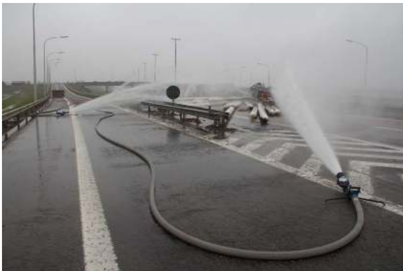
Afbeelding 7.1 Koeling van de gascilinders (foto: Hulpverleningszone Waasland)
