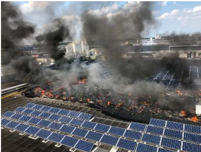
Afbeelding 6.1 Brand op het dak van de Heineken (foto: Brandweer Brabant-Noord)
