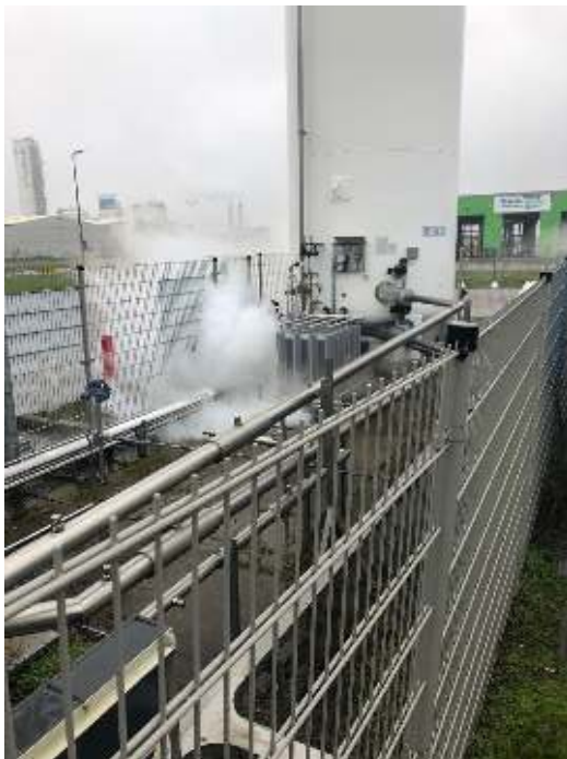
Afbeelding 8.2 Lekkage van de LNG-tank (foto: Veiligheidsregio Rotterdam-Rijnmond)
