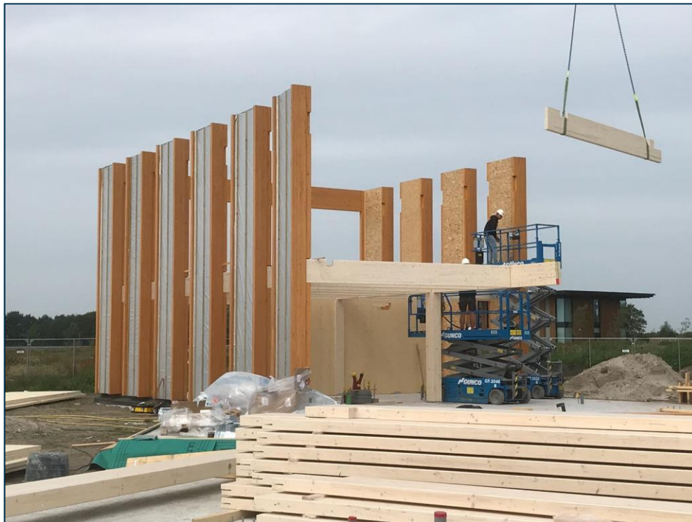
Figuur 5-1 Het houten skelet van het Biosintrum in aanbouw (bron: Biobound).
