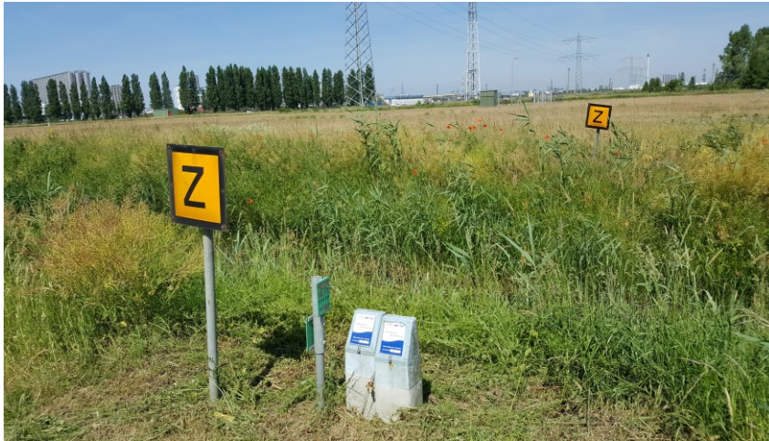
Afbeelding 4.2 Aanduiding dat er een buisleiding onder de waterweg doorloopt (een 'zinker')
