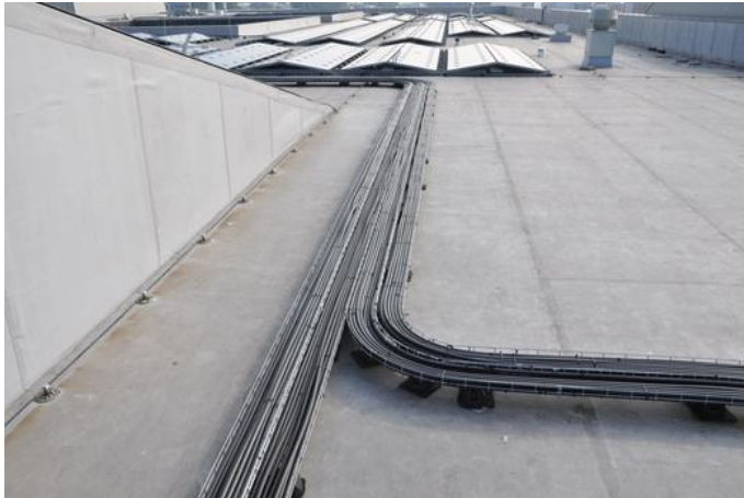
Kabeltracé met transportkabels. Bron: TBO GM
