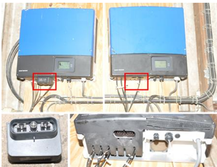
Cascade-opstelling van omvormer met DC-plug. Bron: TBO GM
