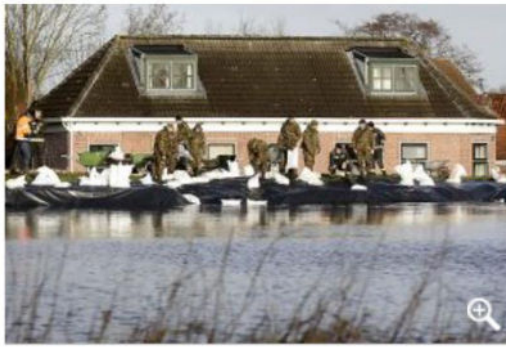
Militairen plaatsen zandzakken op de dijk van het Eemskanaal in het dorp Woltersum bij de stad Groningen. Foto ANP
