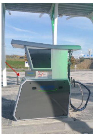
Afbeelding B3.8 Twee soorten afleverzuilen met noodknop (rode pijl)
