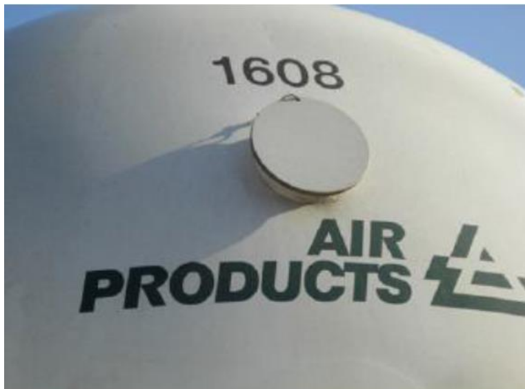
Afbeelding B2.15 Blow-off disc
