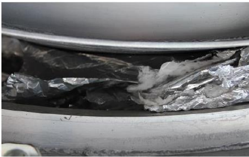
Afbeelding B2.11 Isolatiemateriaal tussen binnen- en buitentank
