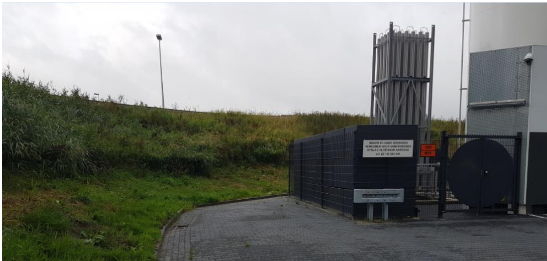
Afbeelding 7.2 Betonnen buildingblocks ter bescherming van de LNG-installatie (J. Keyser)
