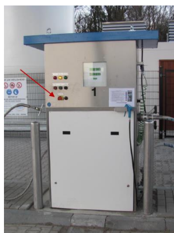
Afbeelding B3.8 Twee soorten afleverzuilen met noodknop (rode pijl)
