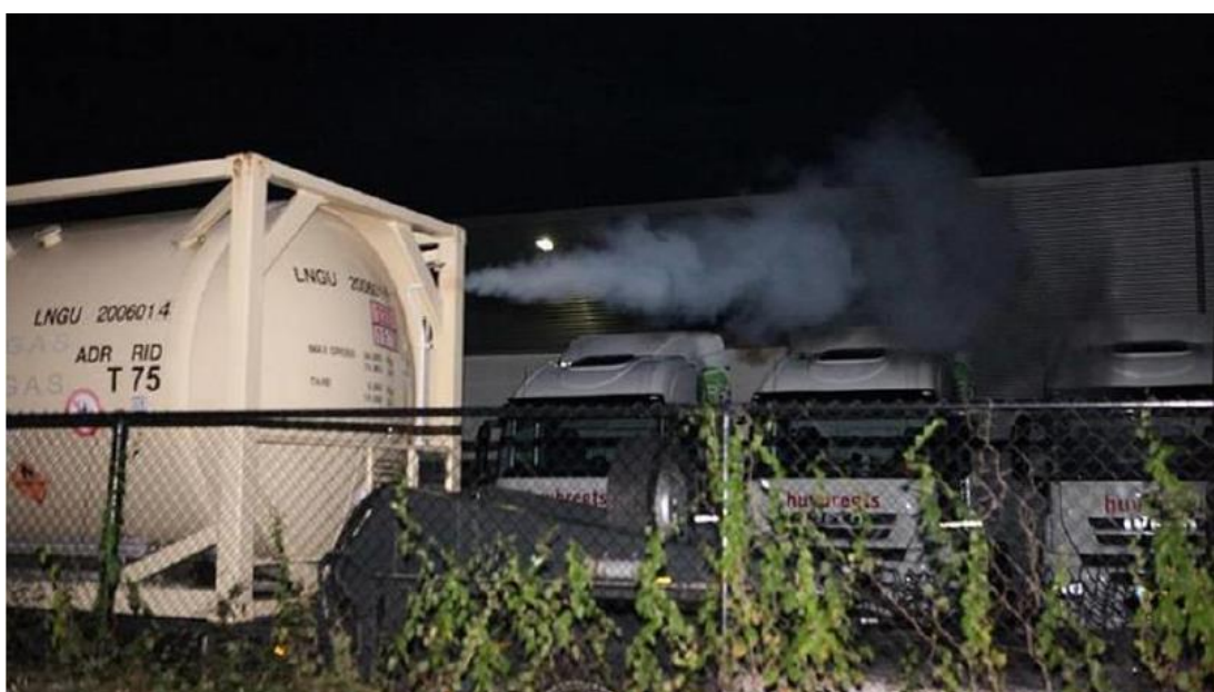
Afbeelding B2.16 Afblaasventiel in werking (vorming BOG). Dit is een normaal proces, maar niet gewenst!
