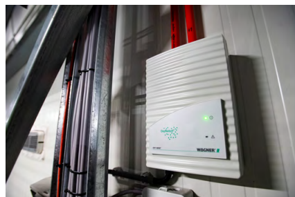
Figuur 9.1 Zuurstof aspiratie sensor
