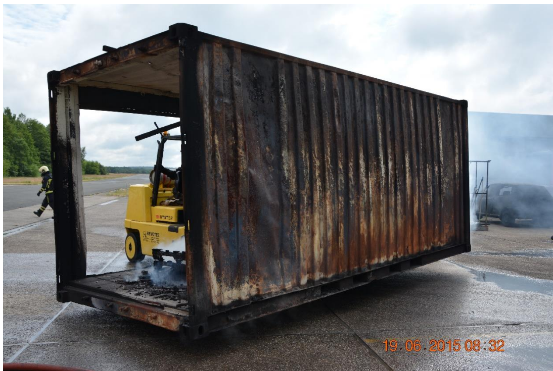
Figuur 6: Opengewerkte zeecontainer
