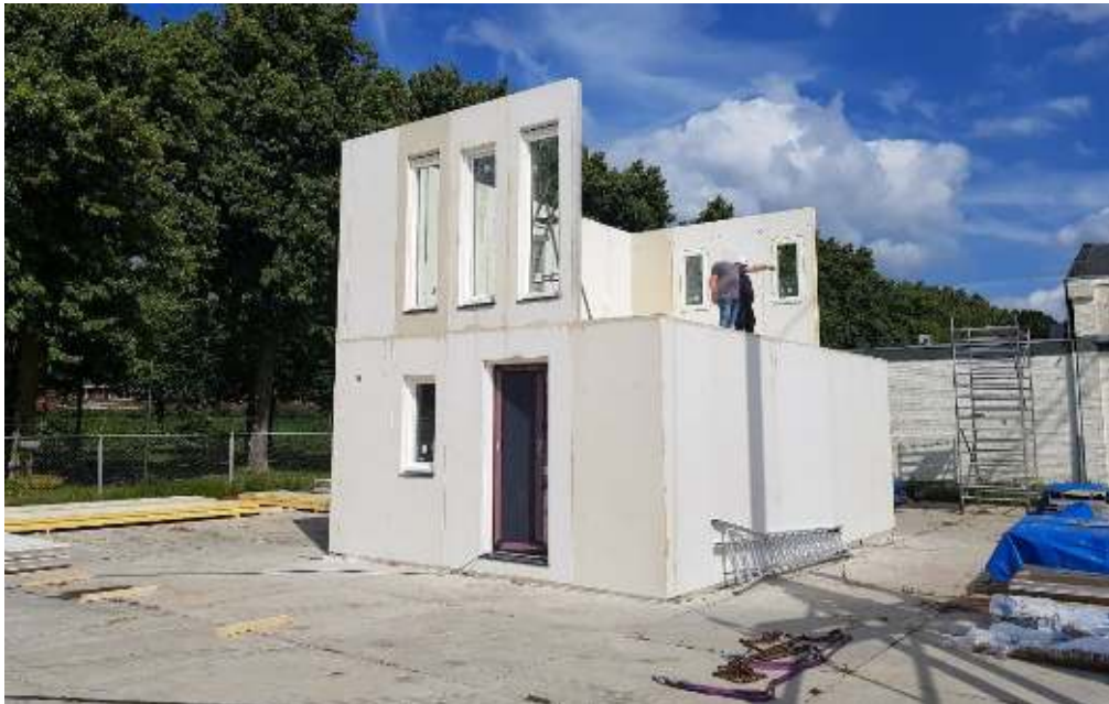
Figuur 4.6 Een proefwoning in aanbouw
