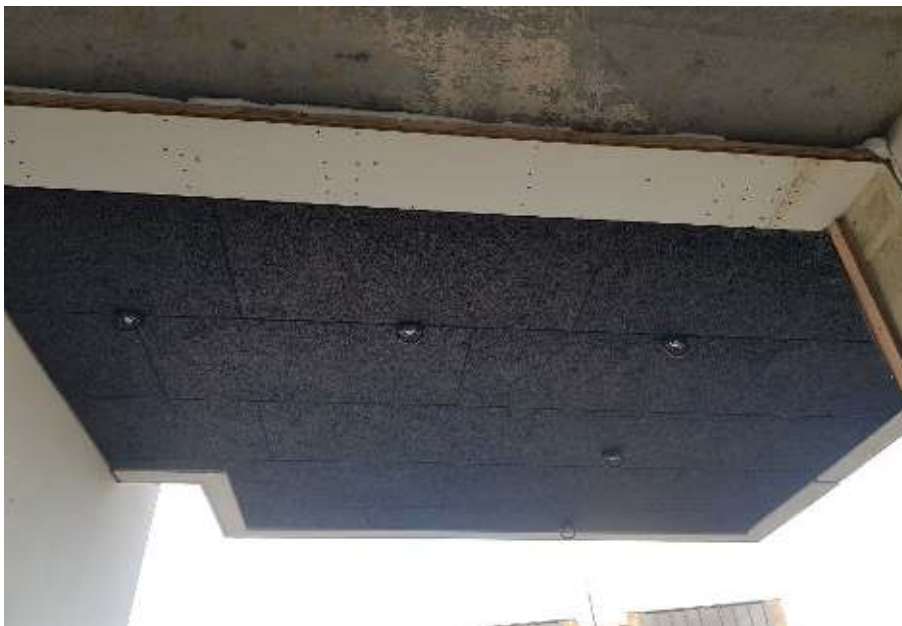
Figuur 4.5 Onderzijde bak afgewerkt met cementvezel platen
