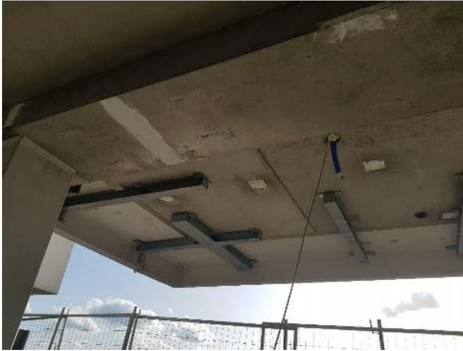
Figuur 4.4 Bevestiging bakken gezien vanaf de onderzijde
