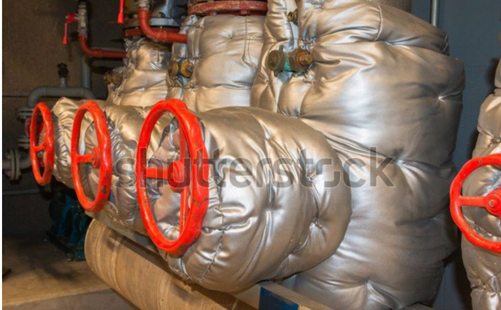
Figuur 2.2 Ter illustratie: industrieel warmtesysteem met isolatie (Bron: Shutterstock)
