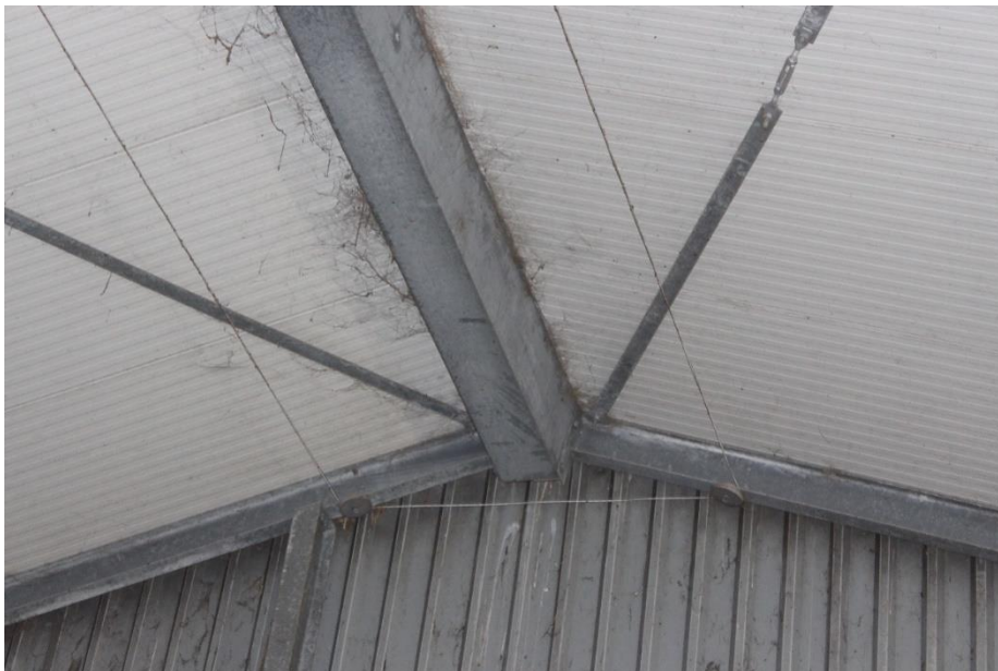
Afbeelding 4.1 Door het aanbrengen van een detectiekoord in de stallen, met een doormelding naar de mobiele telefoon van de eigenaar, is snelle alarmering mogelijk
