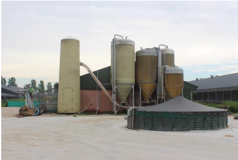
Afbeelding 2.7 Voersilo's, met op de voorgrond een mestsilo
