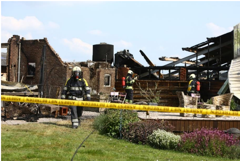
Afbeelding 5.4 Brand in een veestal, waarbij asbest is vrijgekomen
