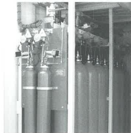
Figuur 3. Pneumatische aansturing met tijdvertraging.
