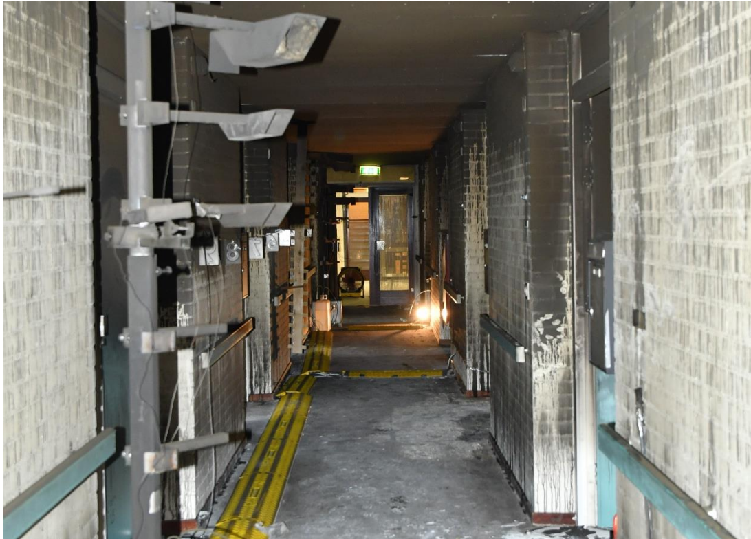
Figuur 2.1: Testopstelling in pandige gang
