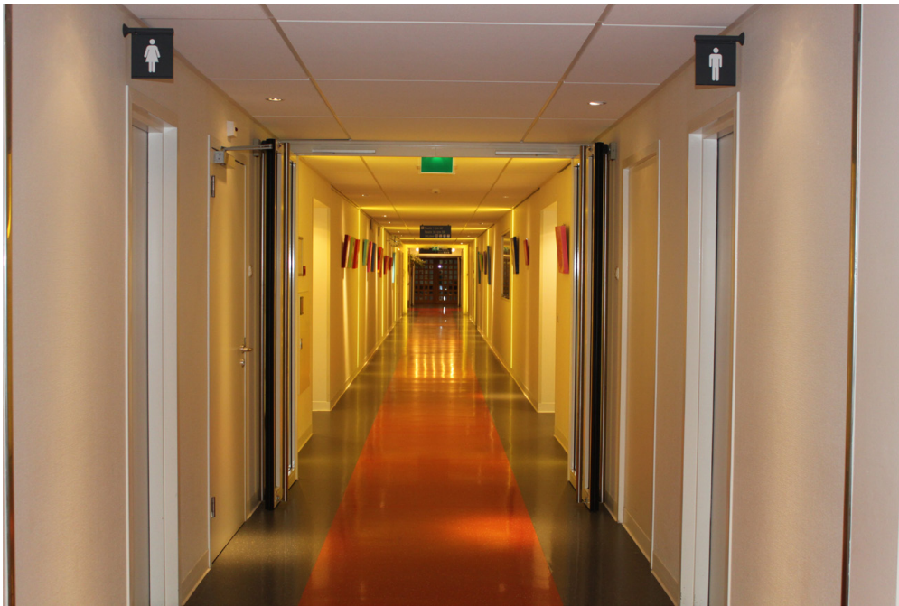
Foto 5.8: Ziekenhuis met subbrandcompartimentering
