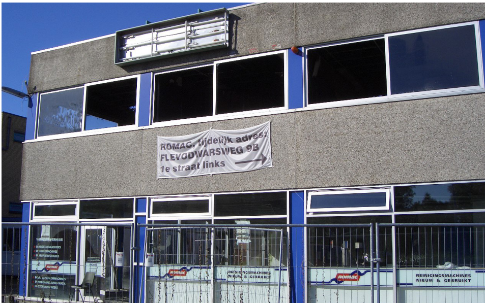
Foto 7.3. Brand met bijna-ongevallen waar brandbare isolatie bij betrokken was (Leiden 2005)
