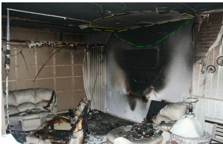
Foto 13.2: Als de meubels nog op hun plaats staan, is het brandpatroon vaak goed te herleiden
