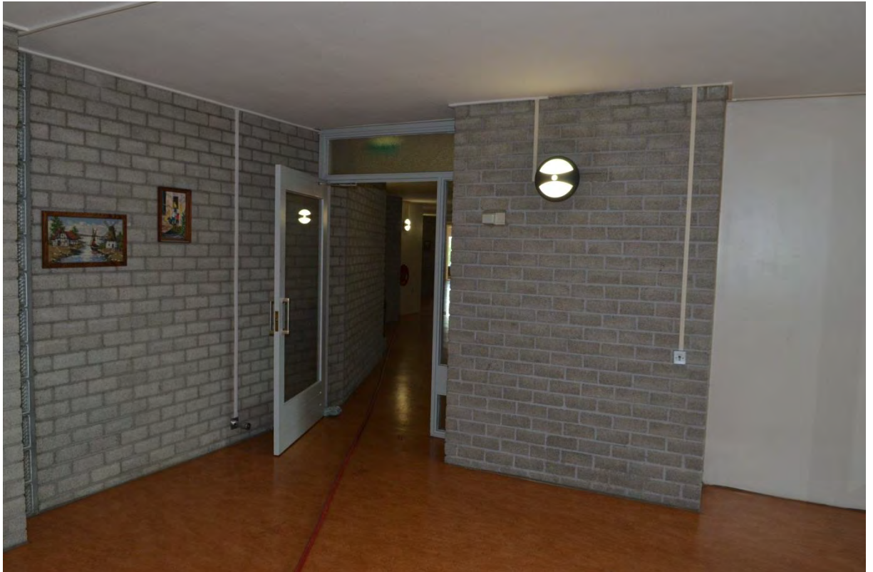
Foto 19. Ook ten gevolge van de gebruikte brandslanghaspels zijn rookwerende deuren tijdens de brand open blijven staan. Foto: Brandweer Rotterdam-Rijnmond
