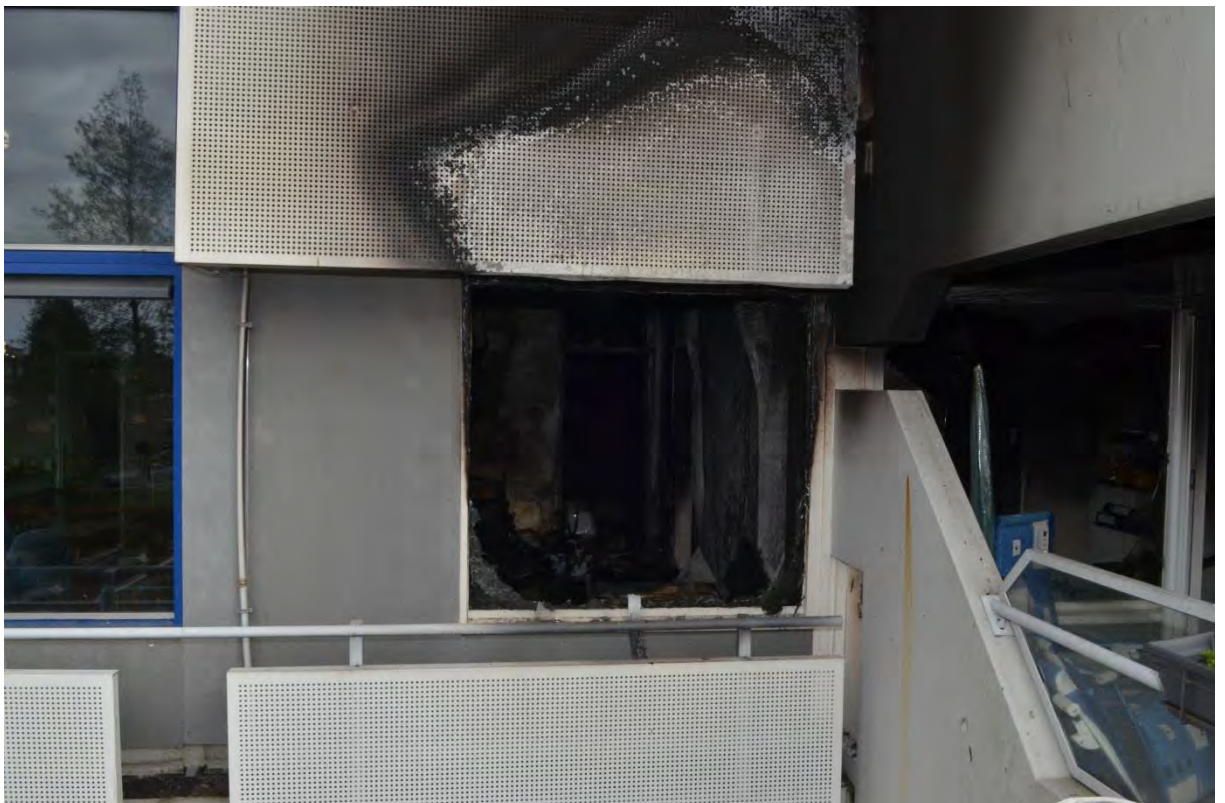
Foto 10. De brandwoning van buitenaf. Foto: Brandweer Rotterdam-Rijnmond
