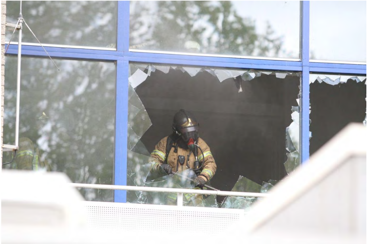
Foto 3. Door de brandweer moesten openingen worden gecreëerd om de inpandige gangen te kunnen ventileren. Foto: Rémon Duivestein Fotografie
