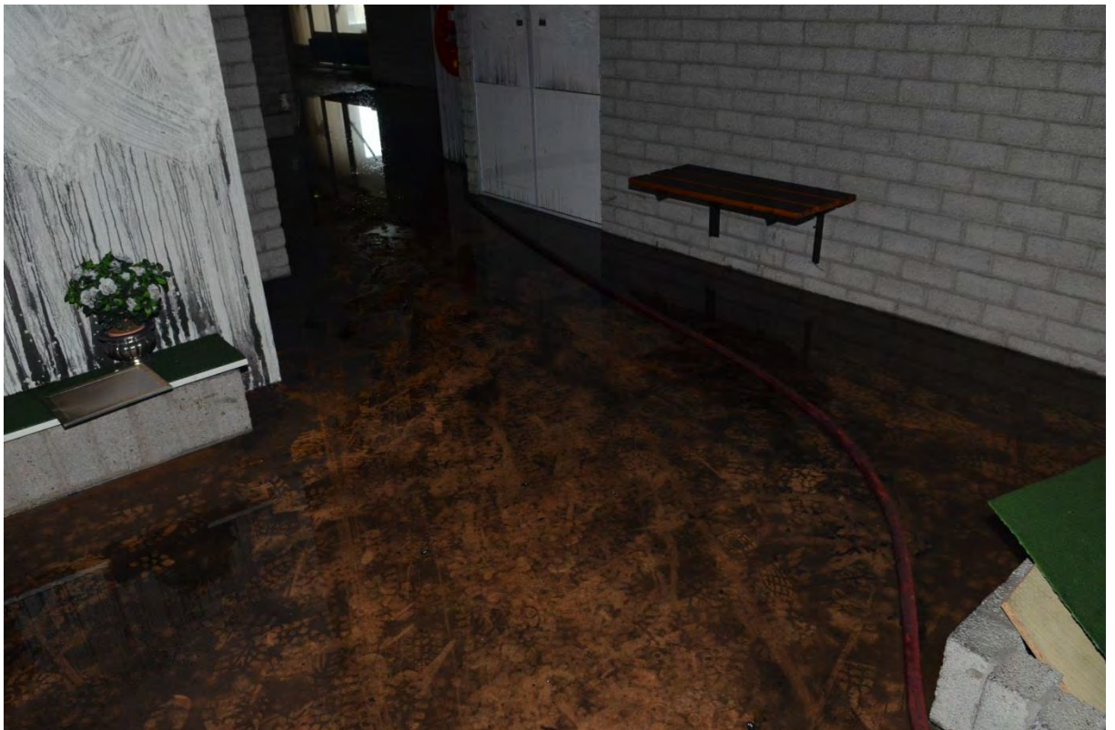
Foto 14. Overal in de gang op de brandverdieping lag een zware roetaanslag. Foto: Brandweer Rotterdam-Rijnmond
