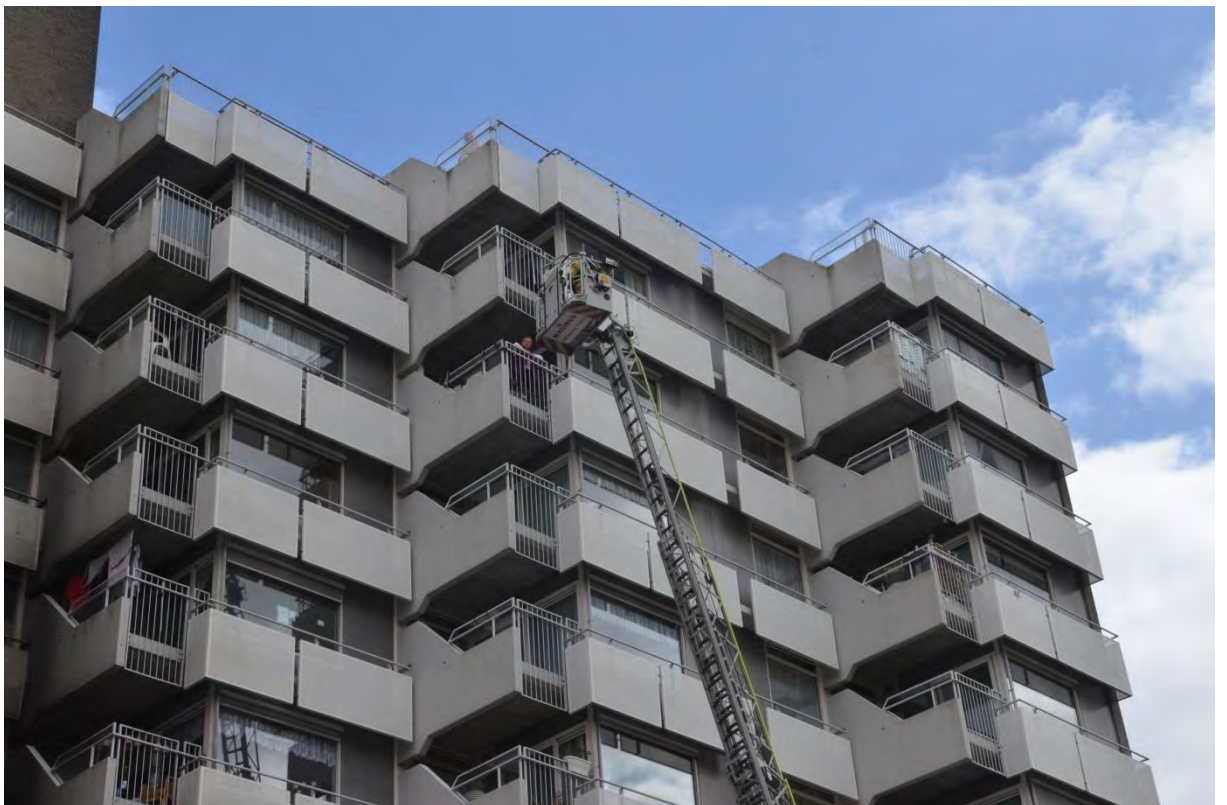
Foto 4. Met behulp van een autoladder worden bewoners van balkons van bovengeslagen verdiepingen gehaald. Foto: Brandweer Rotterdam-Rijnmond
