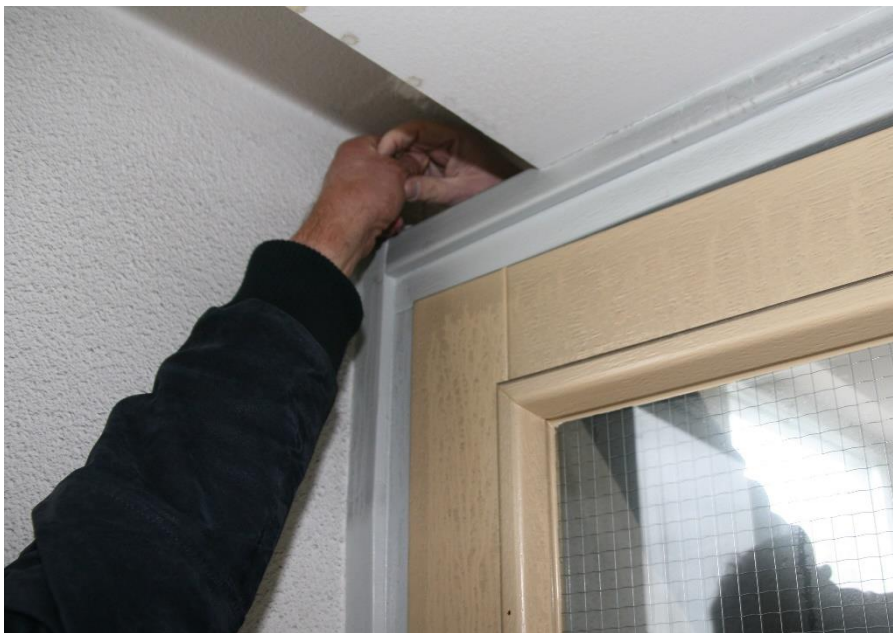
Figuur 4: opening boven rookwerende deur galerij
