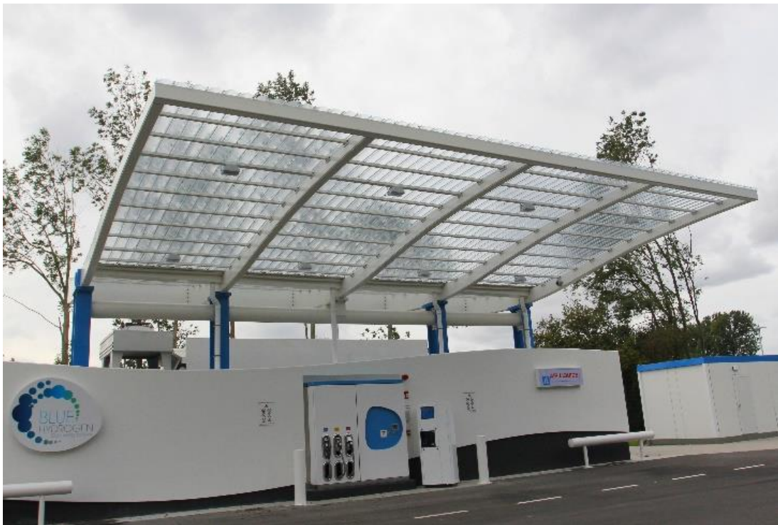
Afbeelding I.1 Waterstoftankstation in Rhooon (BAM Bouw en Techniek)
