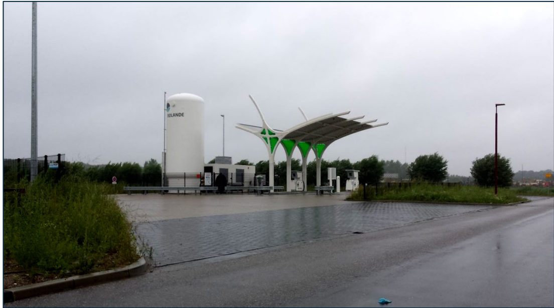
Figuur 1.1 LNG-tankstation Nieuwegein
